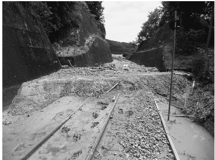
写真 2-1-2 土砂で不通になった線路
