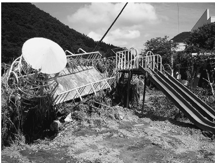
写真 2-1-3 被害を受けた久崎保育園
