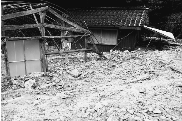
写真 2-1-1 土砂に埋もれた民家
