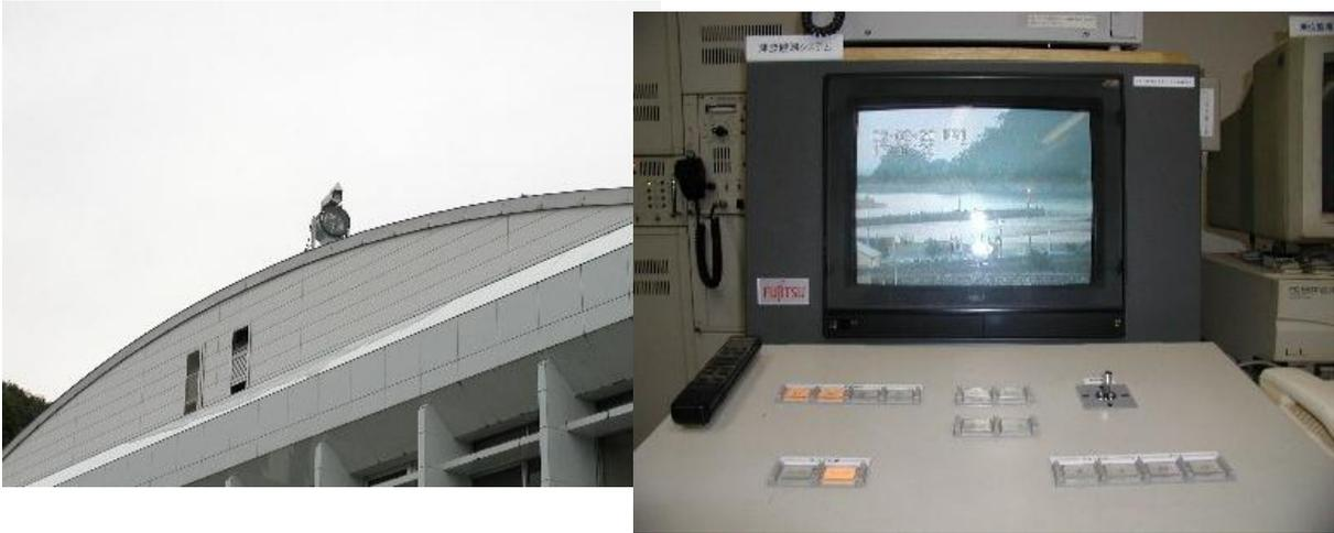
写真 2-5 津波観測システム（左：カメラ（総合事務所屋上）、右：モニター）
