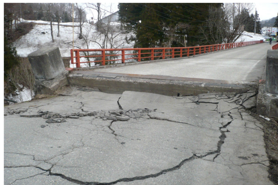
写真 3-2 村内の橋梁被害（青倉地区）
