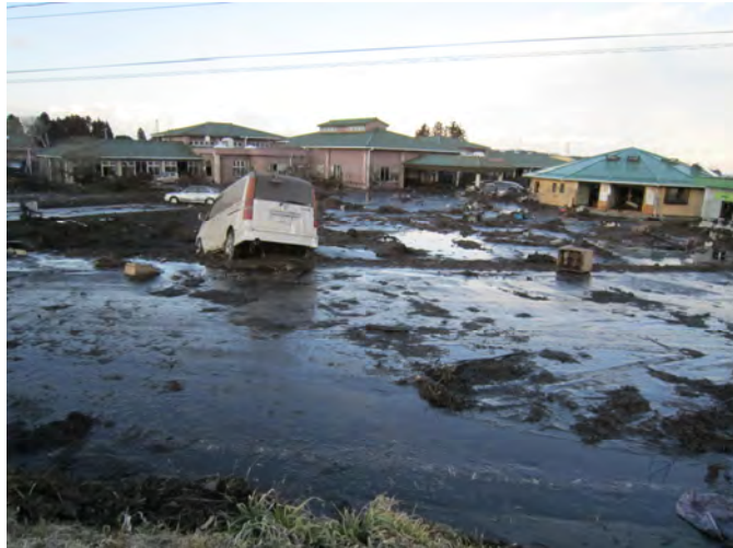
老人保健施設の被災状況
