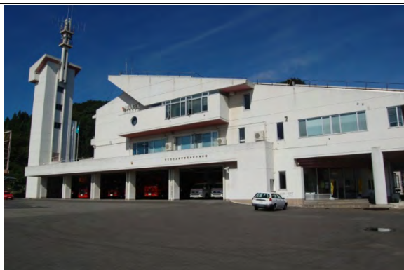
宮古地区広域行政組合消防本部・宮古消防署
