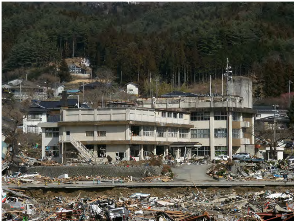
写真 2-3 三陸支所（平成 23 年 3 月 13 日撮影、現在は庁舎撤去）
