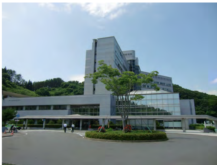
災害拠点病院の県立宮古病院
