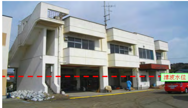
平消防署四倉分署の被害状況
