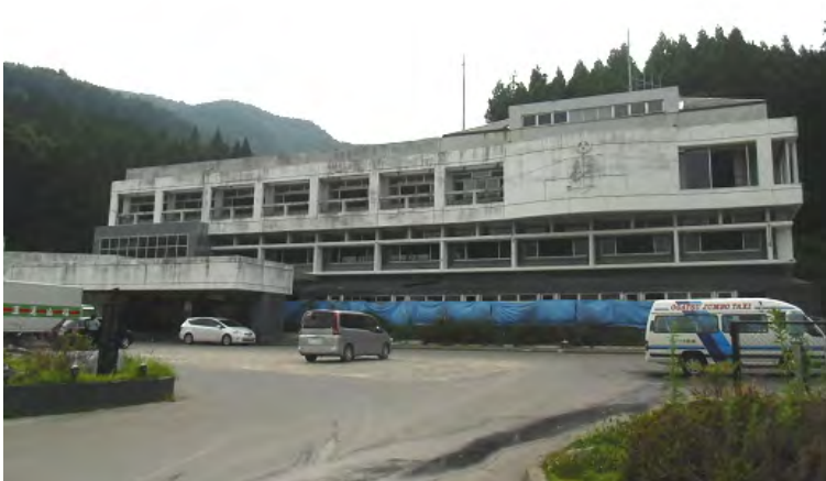
写真 2-8 雄勝総合支所（平成 24 年 8 月 6 日撮影）
