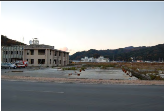
釜石大槌地区行政事務組合消防本部大槌消防署所在地 津波により2階上まで水没し使用不能となる。既に庁舎は取り壊されている。写真左は使用不能となった町役場。
