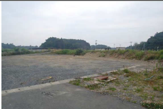
石巻地区広域行政事務組合消防本部鳴瀬出張所所在地 鳴瀬川河口付近にあり1階上まで水没。使用不能となり、直後は鳴瀬総合支所内に移転していた。既に庁舎は取り壊されている。
