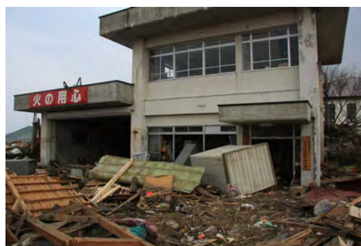
津波で壊滅した野田分署
