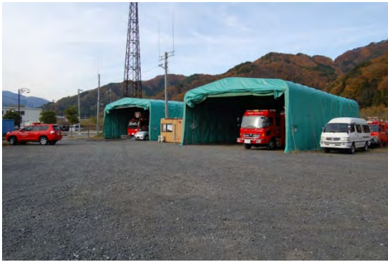
釜石大槌地区行政事務組合消防本部釜石消防署(仮設) 釜石市教育センター付近に仮設の釜石消防署は設置されている。車庫は大型テント、事務室等はプレハブを活用している。
