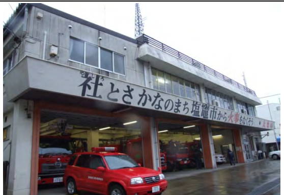
塩釜地区消防事務組合消防本部 塩釜消防署 消防本部のすぐ前に建っている。津波は車庫前まで押し寄せたが、標高もあり庁舎に被害はなかった。
