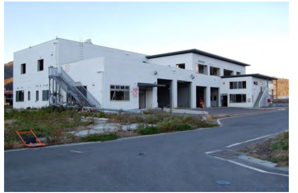
釜石大槌地区行政事務組合消防本部 鶴住居出張所 近年整備された署所であるが、津波により2階上まで水没し使用不能となる。
