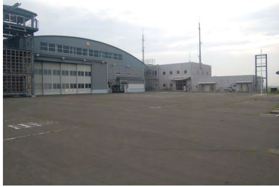
仙台市消防局 若林消防署荒浜航空分署所在地
