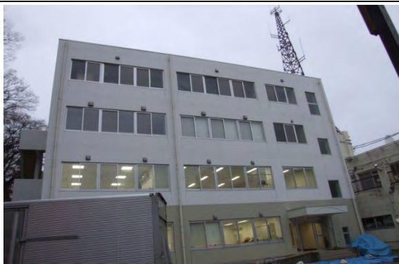
塩釜地区消防事務組合消防本部 庁舎完成し引き渡し直前に震災が発生した。大きな被害は無かった。
