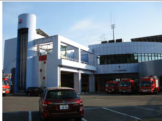
いわき市消防本部 常磐消防署
