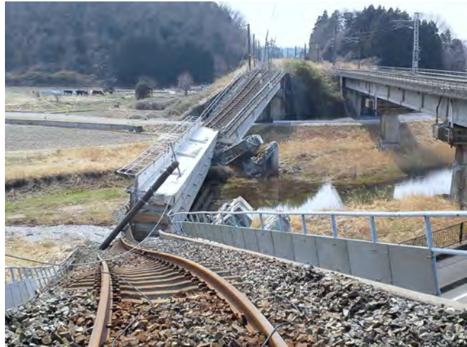
管内調査（常磐線双葉町前田地内）
