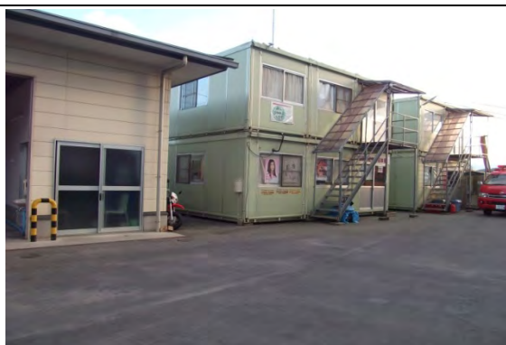
陸前高田市消防本部・陸前高田市消防署(仮設)
