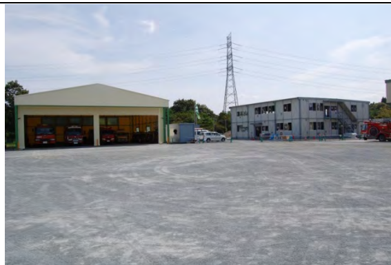
双葉地方広域市町村圏組合消防本部 柵葉分署 敷地は広く、仮設車庫には避難した所属車両も置かれている。右の建築物は仮の消防本部であり、H24年9月から機能移転した。
