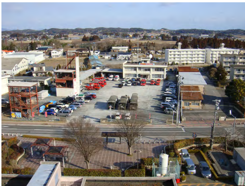
相馬地方広域消防本部・南相馬消防署全景
