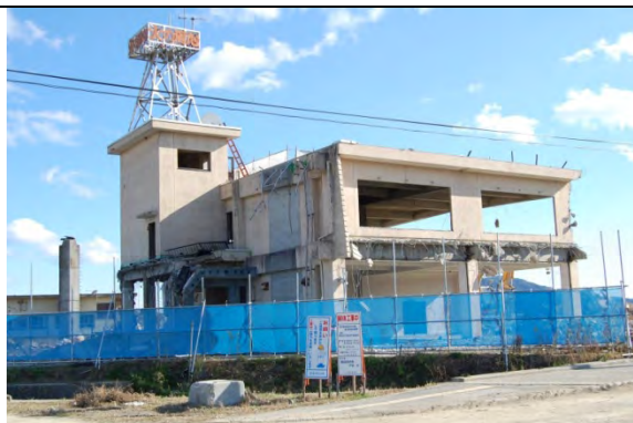
陸前高田市消防本部・陸前高田市消防署所在地
