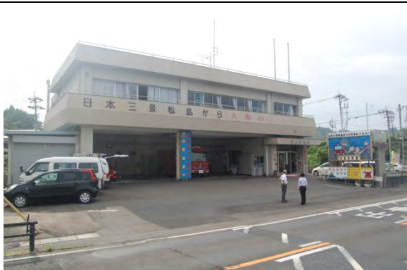
塩釜地区消防事務組合消防本部 松島消防署 松島湾につながる河口に面して建っている。津波による被害はなかったが、敷地が地盤沈下し、段差や亀裂が多数発生した。
