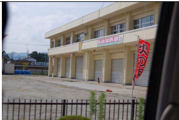
双葉地方広域市町村圏組合消防本部 富岡消防署所在地 消防本部・浪江署と同様、福島第一原子力発電所に近い。地震被害と原子力災害のため使用不能となる。
