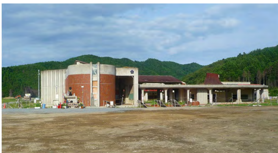
写真 2-11 大川小学校跡地の様子（平成24年8月6日撮影）
