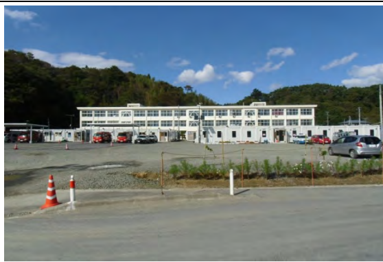
石巻地区広域行政事務組合消防本部鳴瀬出張所(仮設) 野蒜小学校敷地内に関係機関と併せて仮の出張所を構え業務を実施している。仮設の出張所は写真一番左にある。
