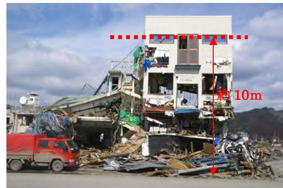
被災した大槌消防署
