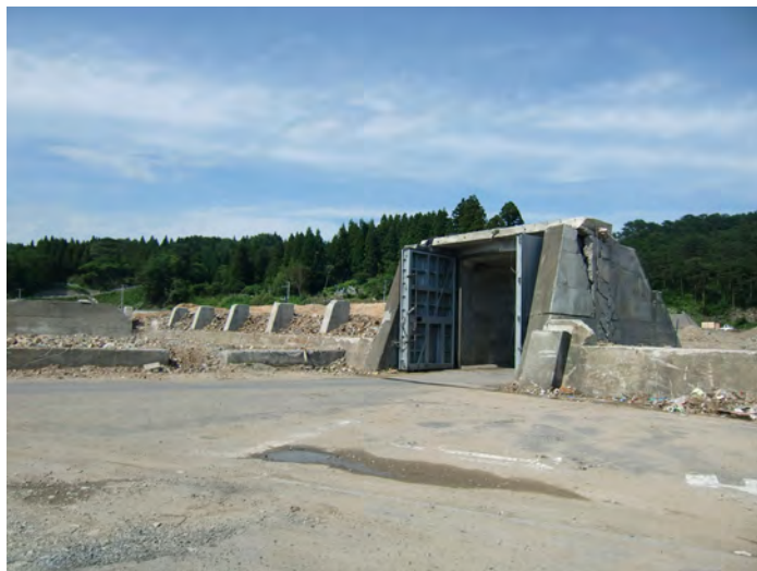
津波で損壊した田老地区の防潮堤
