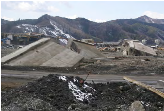
倒壊した防波堤
