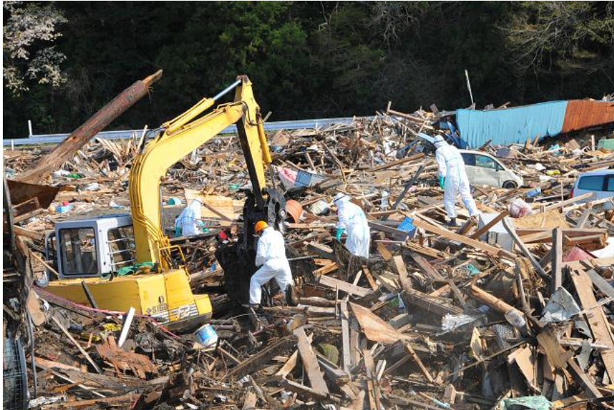
写真 2-6 重機を使った遺体捜索（請戸地区）
