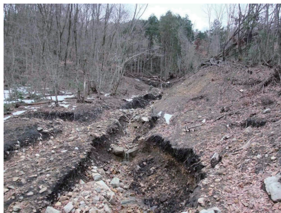
写真2 土砂移動の経路沿いのクロボク（2011年2月28日撮影）
