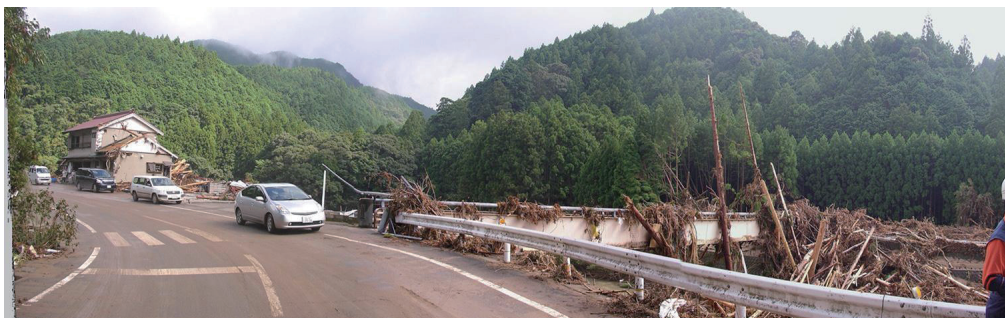
図3 新宮市相賀の家屋流出（手前から2台目の車両の脇に家屋があった） （2012年9月12日撮影）
