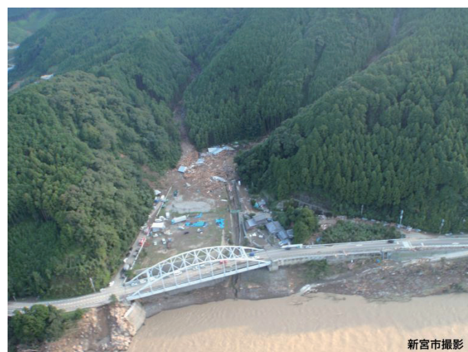
図6 新宮市南檜杖の土石流
