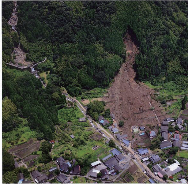
写真2 砂防堰堤（写真左端）の災害防止効果（中園川）（(株)パスコ提供）
