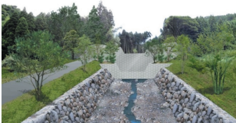
(イメージ) 自然石を活用した流路工
