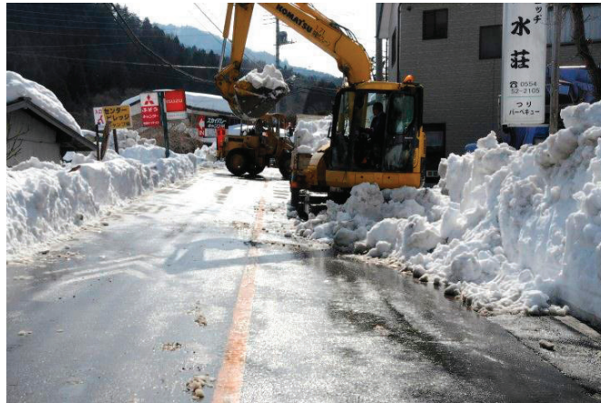
写真：除雪作業の様子（道志村提供）
