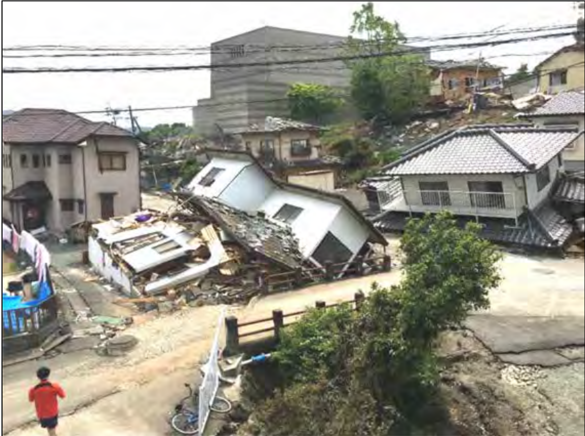
地震による家屋の倒壊
