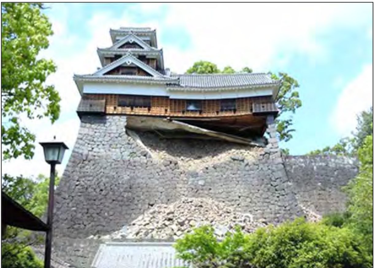
熊本城の被害状況（熊本県熊本市）
