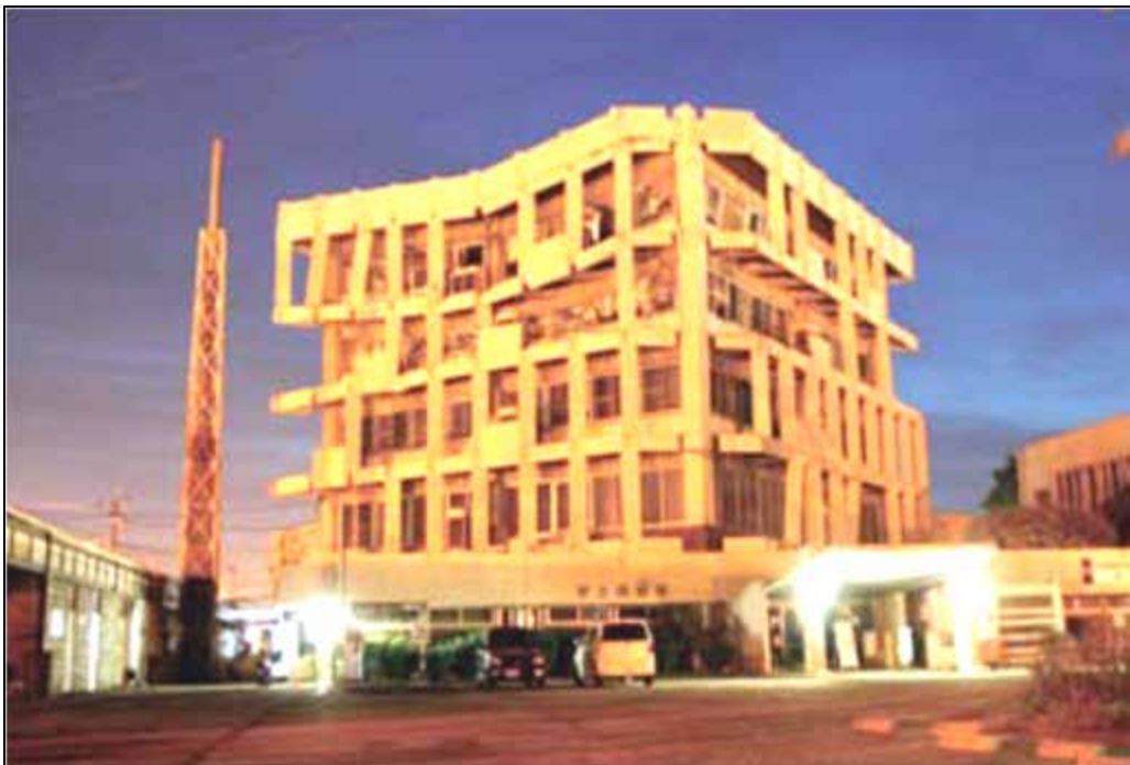
倒壊により使用不要となった宇土市役所
