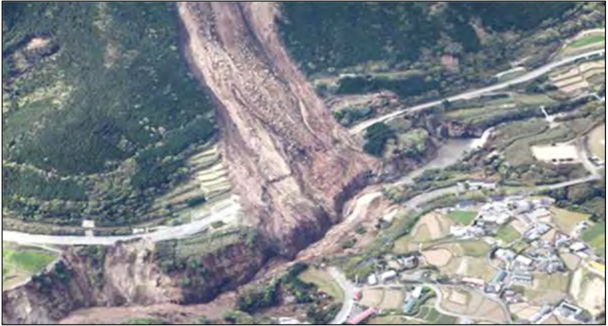
阿蘇大橋付近の被害状況（熊本県阿蘇郡南阿蘇村）
