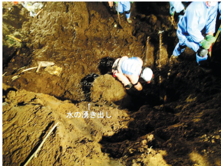
図6 掘削地点からの水の湧き出し状況
