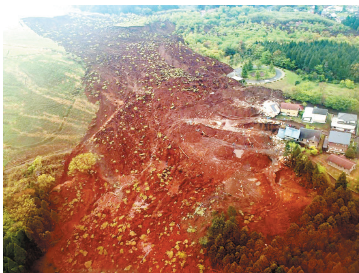
図8 21日の降雨後の河陽高野台の活動サイトの状況
