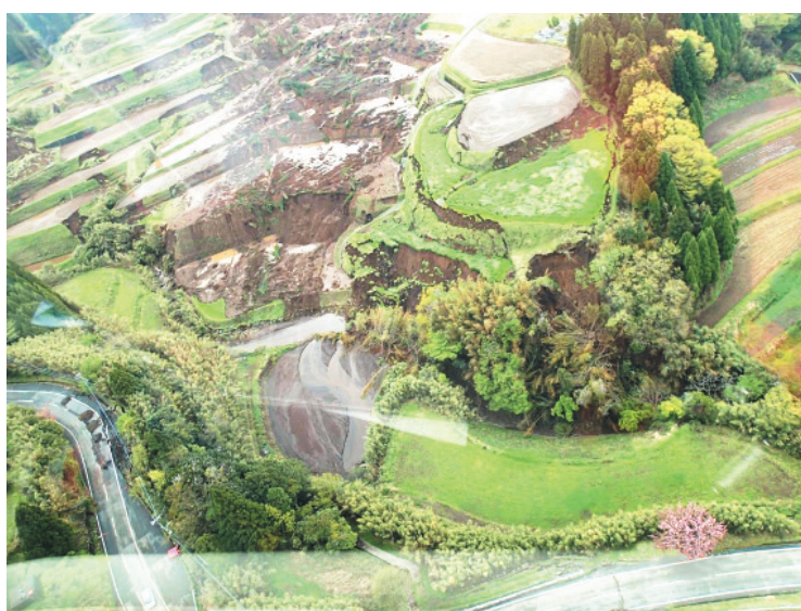
図9 濁川の上流にあった河道閉塞箇所
