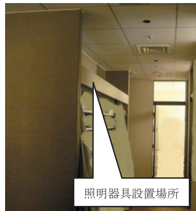
写真1 照明器具設置場所の状況
