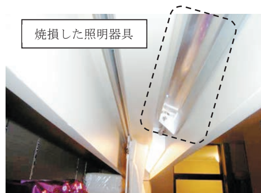
写真2 照明器具の取付状況
