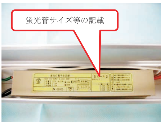
写真4 蛍光灯安定器
