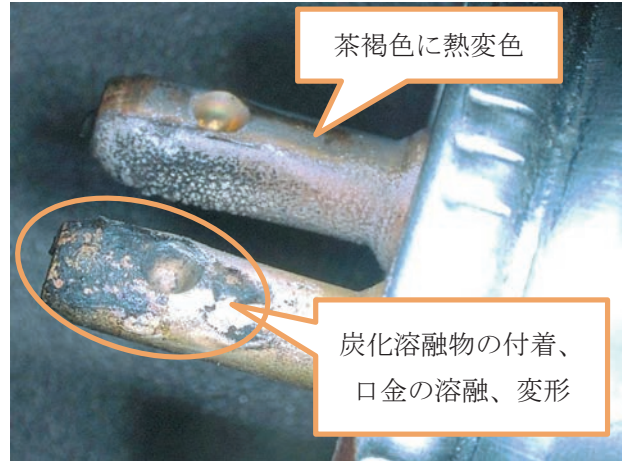
写真9 焼損側の蛍光管口金両面の状況
