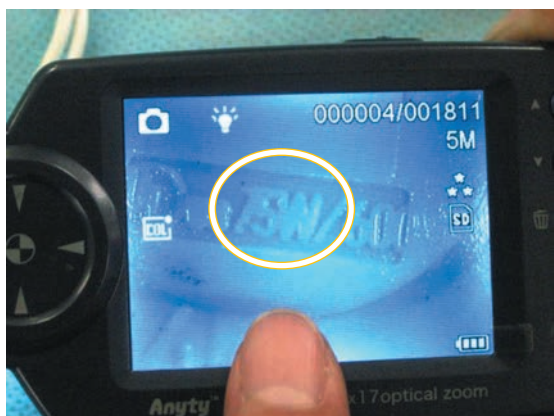
写真16 焼けているソケット
