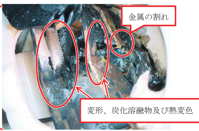
写真7 焼けているソケットの状況
