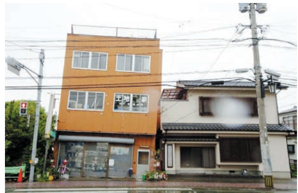
(b) 地盤の液状化により沈下、傾斜が見られる
