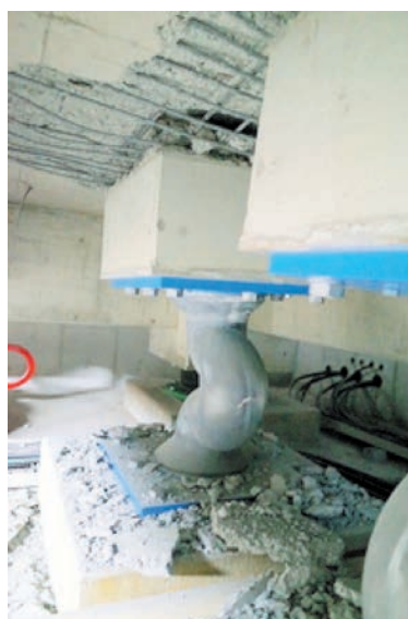
(a) 鉛ダンパー取付け基部の被害 (床スラブの破損)
