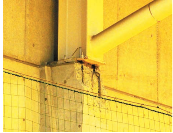
(b) 体育館鉄骨支承部のコンクリートの破壊
