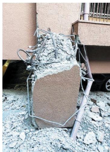
(b) 1階柱の損傷
