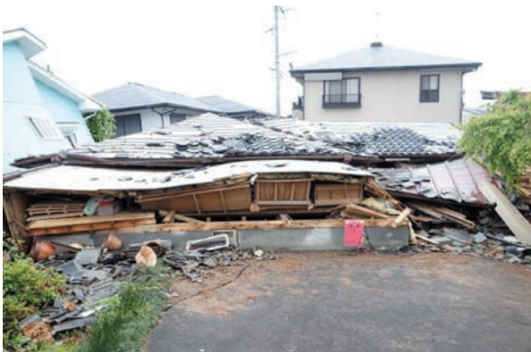
(a) 地盤変状、基礎損傷が見られる
