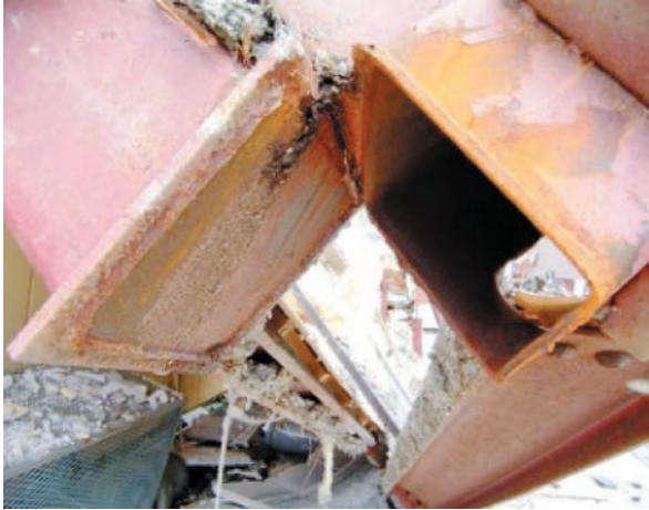
(a) 柱梁接合部の溶接部の破断
