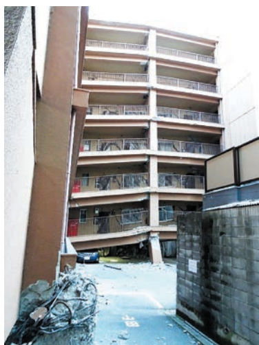
(a) 層崩壊した共同住宅
