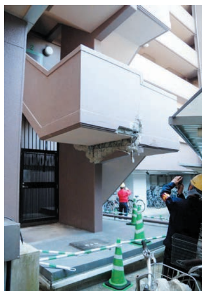
(b) 外付け階段の被害
