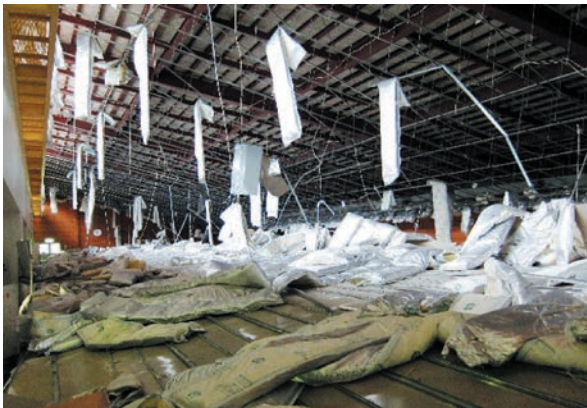
(a) 吊り天井脱落
