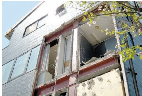
(b) 乾式工法による外壁材の脱落
