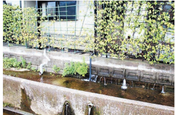
写真-6 益城町で擁壁から溢れ出す地下水
