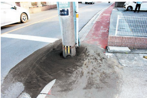
写真-4 近見での液状化現象（電柱が沈んでいる）
