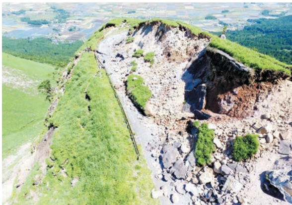
写真-3(a) 阿蘇外輪のラピュタへの道における斜面崩壊 (先阿蘇の亀裂を多く含む溶岩類の崩壊が卓越)
