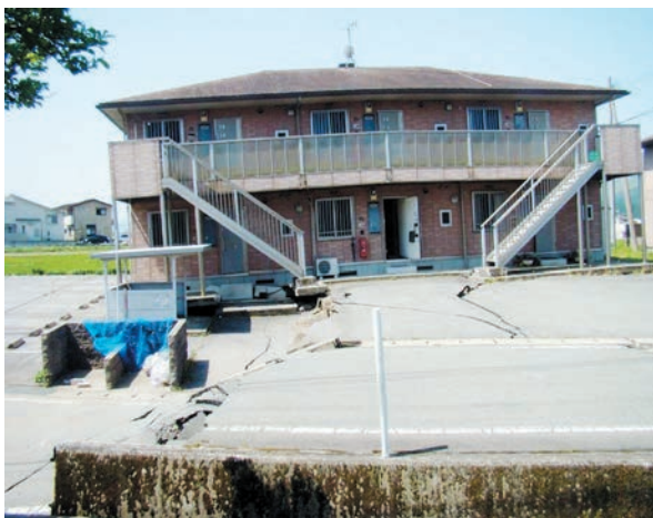
写真-5 内牧地区の陥没（段差は約1m） アパートが向かって左側へ傾いている
