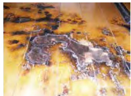
火災現場の床面の焼き状況
