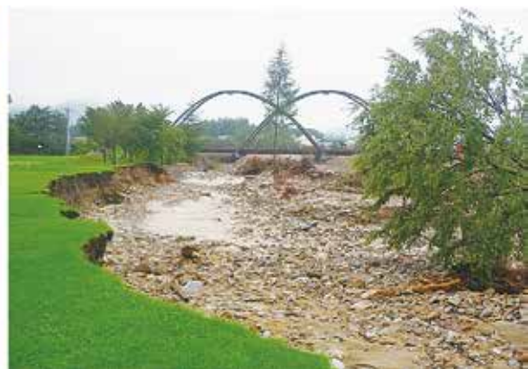
写真2 ペケレベツ川の河岸決壊状況、左)石山橋周辺（9/1撮影、左右岸の連続的な河岸決壊状況）（PASCO 提供）、右)石山橋下流（9/6調査団撮影、河岸決壊の状況）
