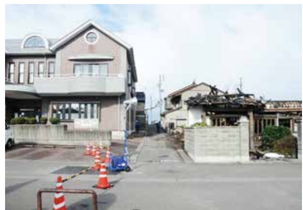
図3 耐火造建物での焼け止まり
