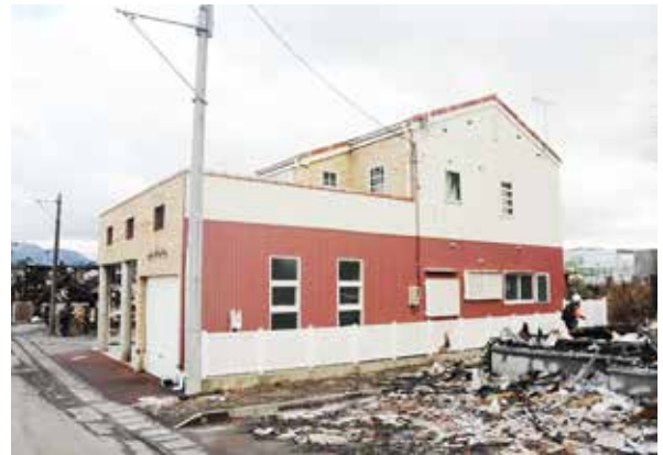
図7 焼損地域内で延焼を免れた住宅
