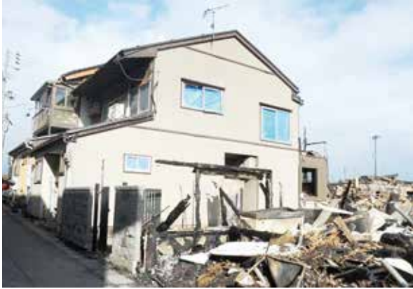
図4 消火活動で延焼が阻止された木造住宅
