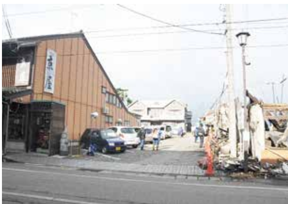
図2 駐車場の空地での焼け止まり
