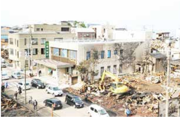
図5 建物内への延焼を免れた耐火造建物
