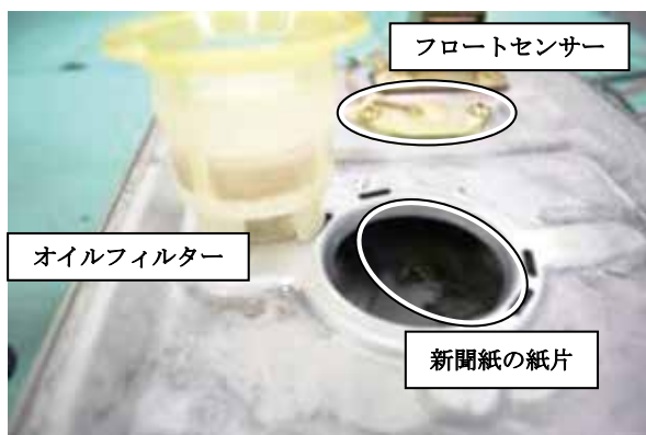
写真8 油受け皿側の状況
