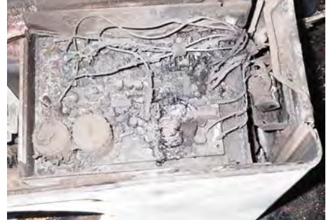
写真4 室外機内部の状況
