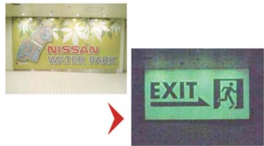
写真 蓄光材を用いた避難誘導表示 1) より引用
