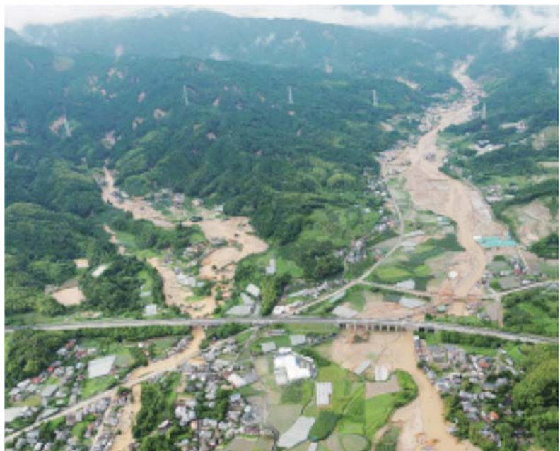
図2 福岡県朝倉市赤谷川流域の被災状況(国土交通省九州地方整備局撮影)
