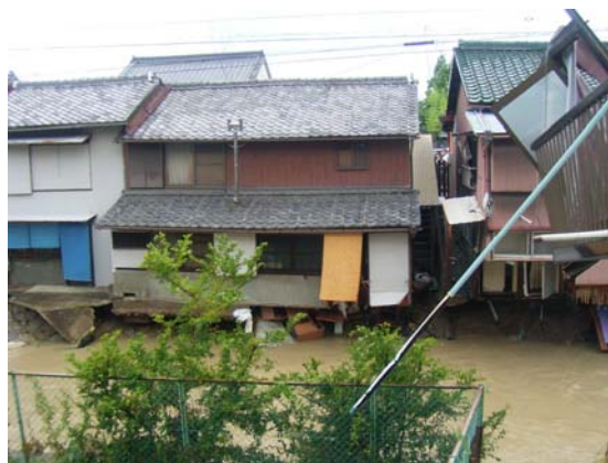
写真 5.1.2 行方不明者が発生した民家 （濁流により1階床部分が崩落）
