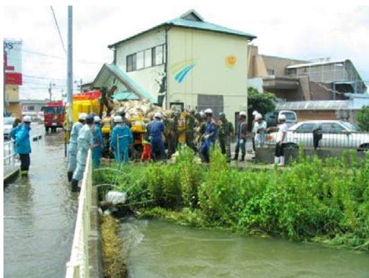
写真 5.2.1 河川溢水に対する土のう積み活動
