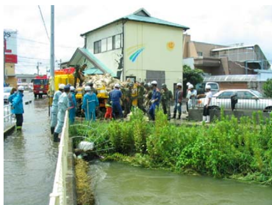
写真5.2.1 河川溢水に対する土のう積み活動
