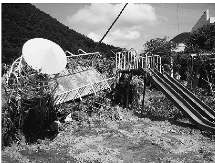
写真 2-1-3 被害を受けた久崎保育園
