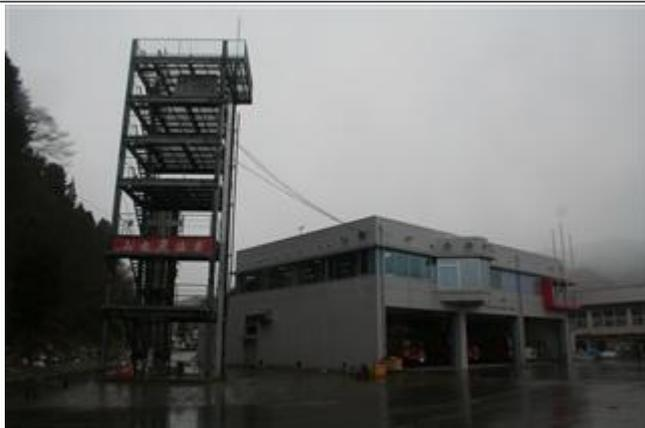
津波により1階部分が被災したが、2階部分を使って震災直後から署所機能は維持された。(H23/4)
