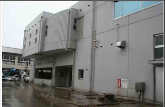
1階部分の部屋は完全に使用不能となった。窓枠も外れている。(H23/4)
