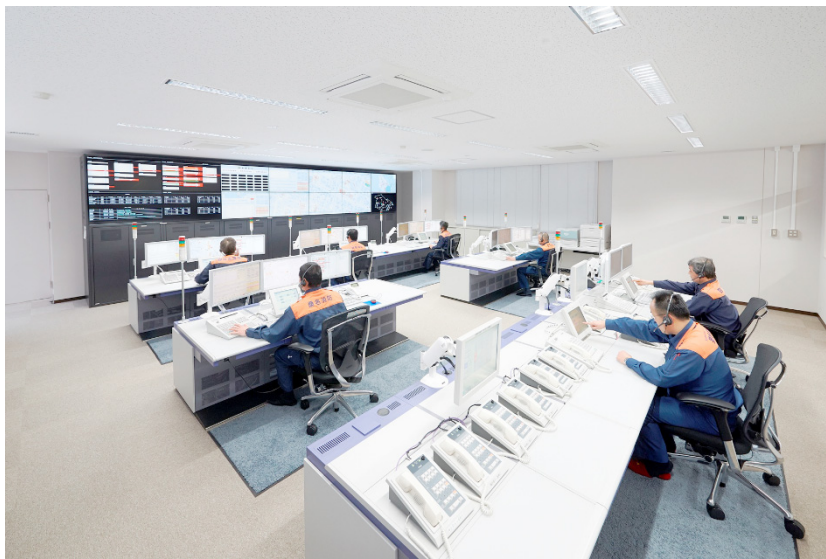
図 2 消防指令センター
