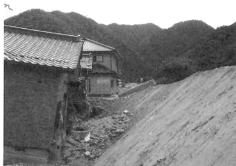
写真1 佐用町久崎地区における被害
