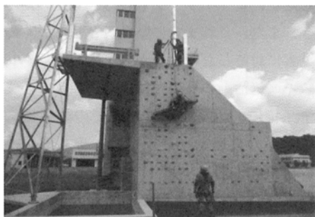
都市型救助訓練施設 (平成22年10月12日開設)
