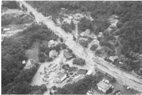
国道262号被災状況（防府市勝坂）
