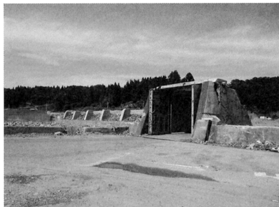
写真 2 津波で損壊した田老地区の防潮堤
