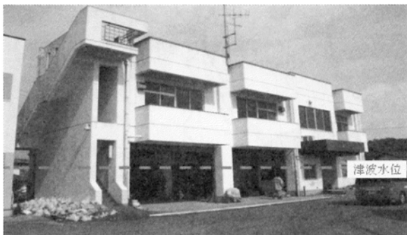
平消防署四倉分署の被害状況
