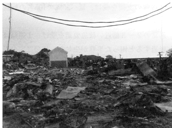
津波と火災の被害を受けた久之浜地区
