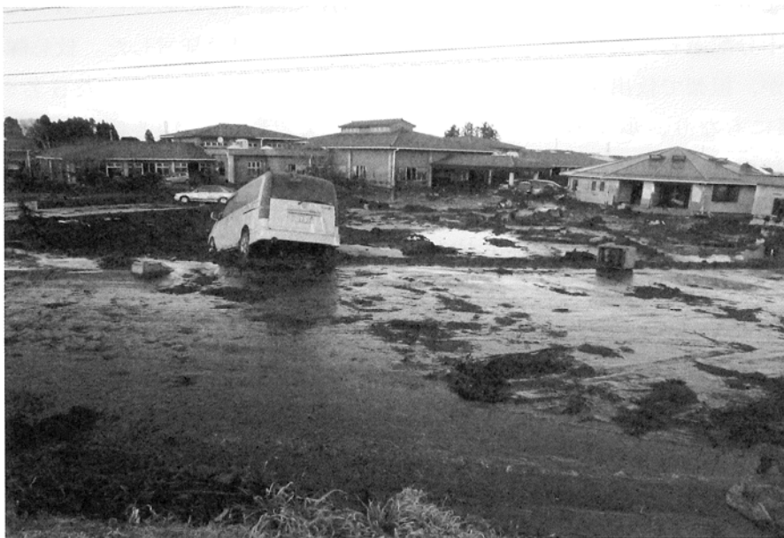
写真 1 老人保健施設の被災状況 (3月11日撮影)
