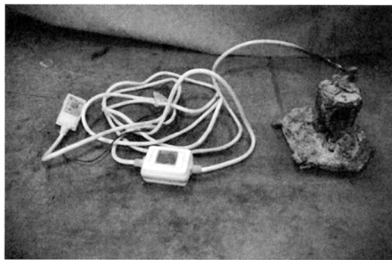
写真：外観の焼損状況
