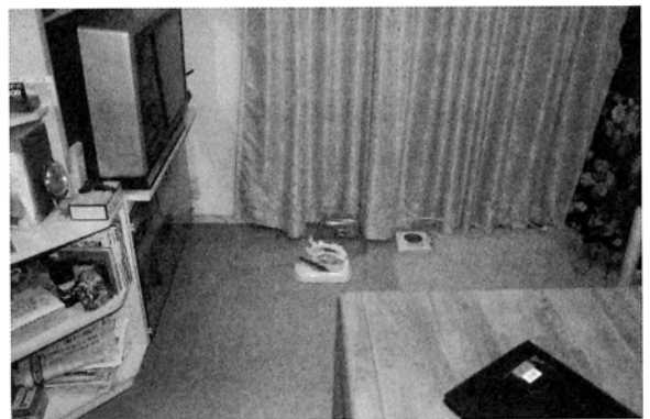
写真：現場の焼損状況
