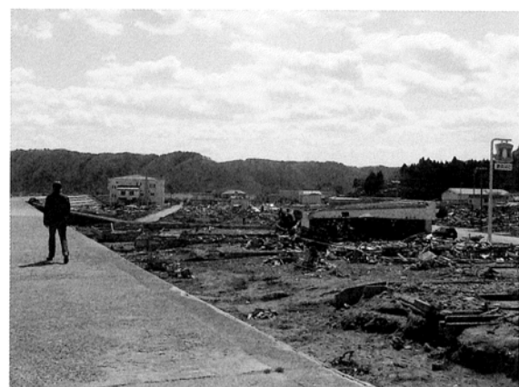
写真2 宮古市田老地区：陸側の防潮堤は残ったが、大津波はそれを超えてまちを壊滅させた
