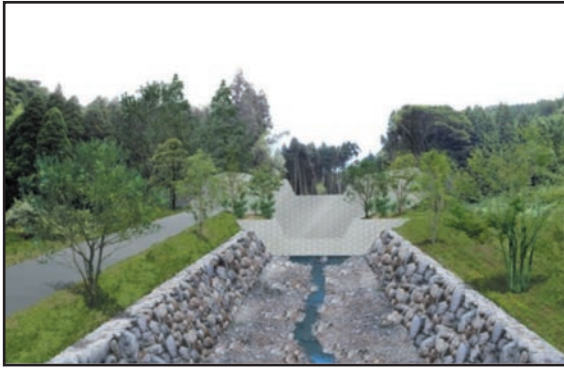
(イメージ) 自然石を活用した流路工
