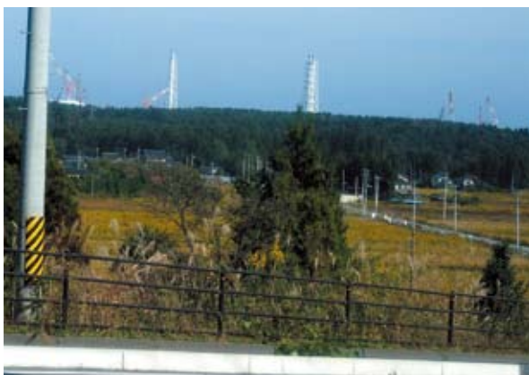
高台から見える原子力発電所（事故後）
