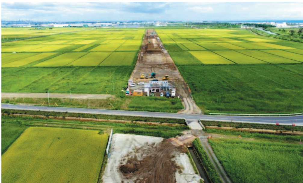
↑ 『整備工事中的かさ上げ道路 (9/2現在)』
