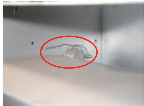
写真8 燃焼室リミットサーモの熱電対
