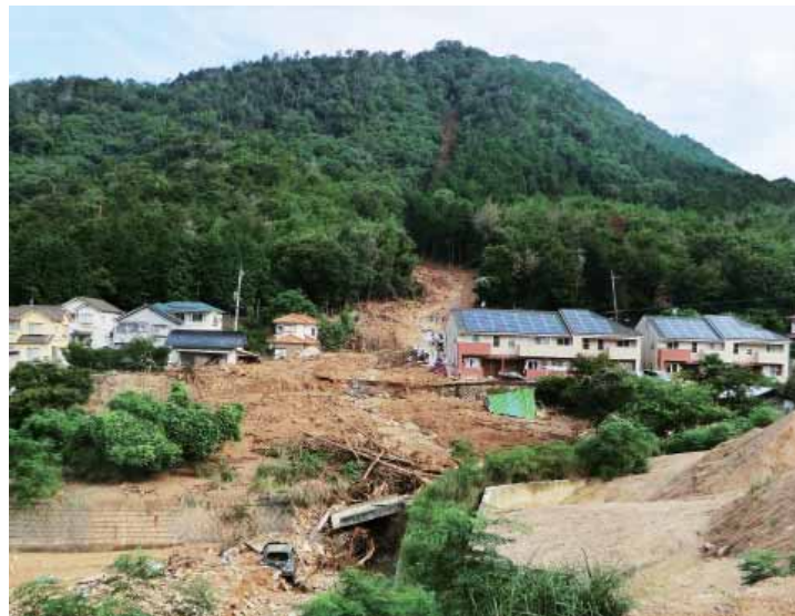
写真5 高松山の尾根沿いから崩れた崩壊の1つ。大量の土砂が堆積しており、複数の民家を直撃している。
