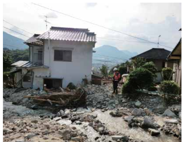
写真8a 住宅地内で水路が流出土砂により堰き止められた地域。赤白スタッフのある位置が元の流路。
