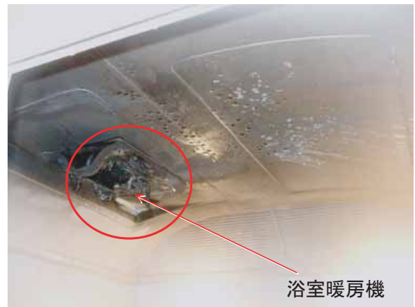
写真1 浴室内天井の状況
