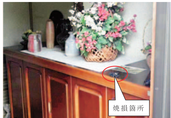
写真No.1 焼損箇所（下駄箱周辺）の状況
