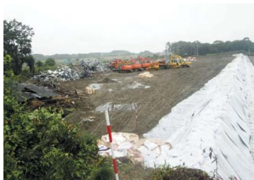
図8 土のうによる仮締切の状況
