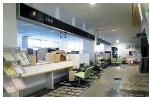
図2 市役所（本庁舎）1Fの様子
