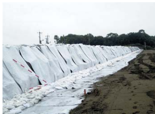
図8 土のうによる仮締切の状況
