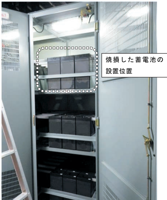
写真2 蓄電池設備盤内部の状況
