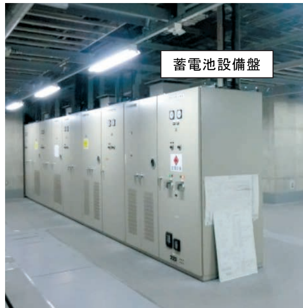
写真1 出火した電気室の状況
