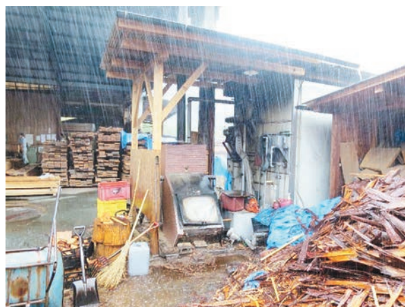
写真2 燃烧中の灰が飛び出したボイラー（建屋修理済） （南小国町赤馬場、2016年8月26日、筆者撮影）
