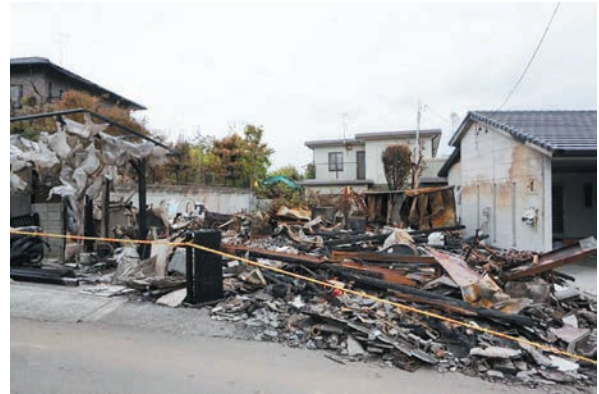
写真1 隣棟への延焼が阻止された戸建住宅火災跡（益城町安永、2016年4月18日、柴田祐氏撮影・提供）
