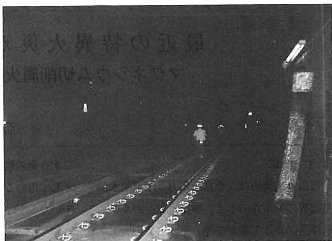
トンネル内部の状況
