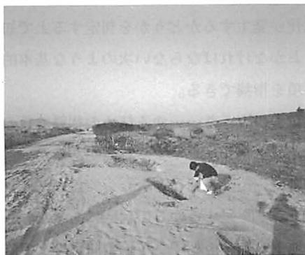
写真-3 日本海中部地震（58.5.26,  $M=7.7$ ）による八郎潟堤防の法尻の噴砂の状況
