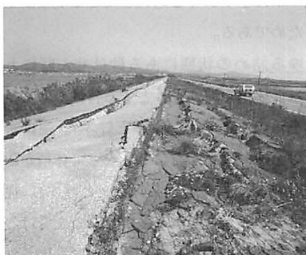
写真-2 日本海中部地震（58.5.26,  $M=7.7$ ）による八郎潟堤防の被害
