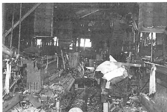
タオル織物工場の焼き状況
