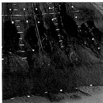
写真—6 斜面末端部の局所的な崩壊の状況
