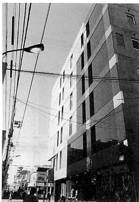
写真2 ビルの外壁に貼られたステンレス板
