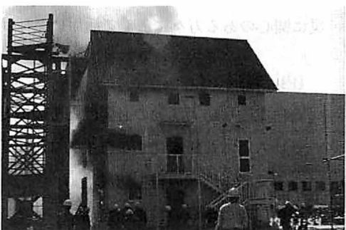
写真6 点火後54分 (北側の東端トイレには延長しているが、西側) (向って右)にはまだ延焼していない。)
