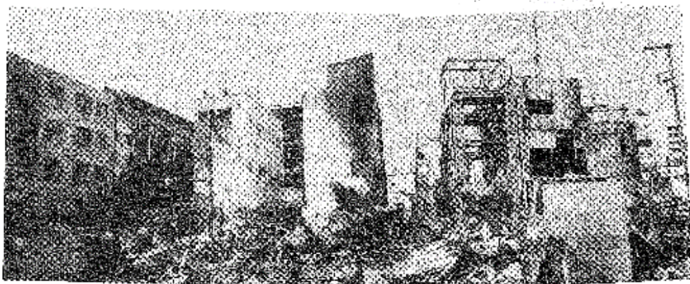
写真2 耐火造であっても外壁の崩落したもの。開口部が大きく破損しやすかったものは延焼し、開口部が小さく複入りガラスであったものは延焼を免れている。
