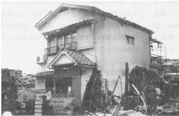
写真3 木造家屋のモルタル外壁は、地震動による剥離やひび割れがなければ立派に延焼阻止の効果を持つことを示す典型例。右側の隣接建物は全焼しているが、中央の家屋は無事だった。
